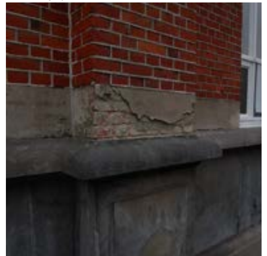
Beschadigd pleisterwerk.
