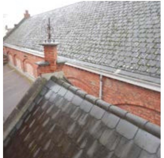
Dak [4]: ijzeren topstuk.
