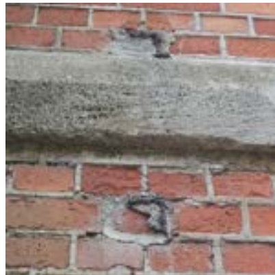
afb. 38: ongebruikte ankers
