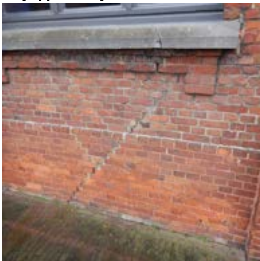
Vleugel [3]: scheurvorming.
