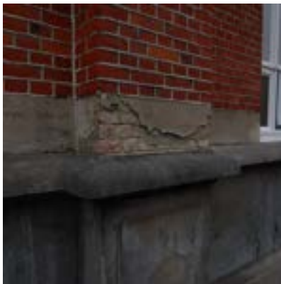
afb. 52: beschadigd pleisterwerk
