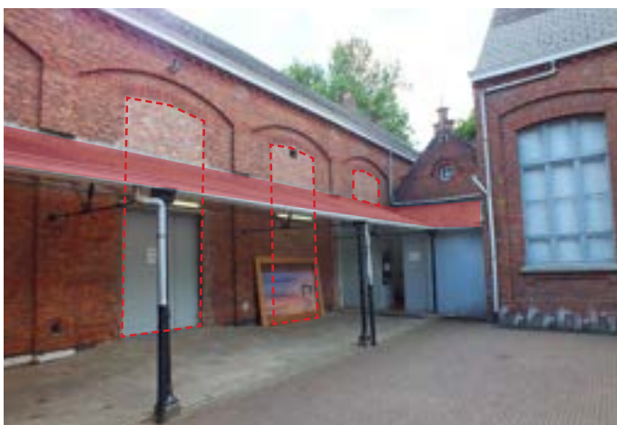
afb. 9: Gedichte gevelopeningen, gaanderij met kunststofplaten en pvc afvoeren (storend)
