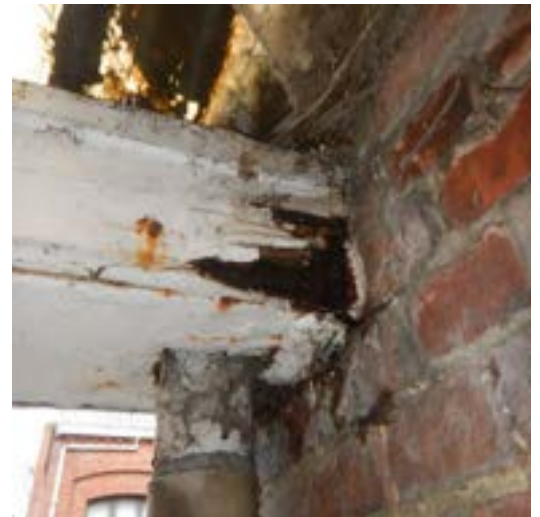
Houten omkasting van de ijzeren goot.
