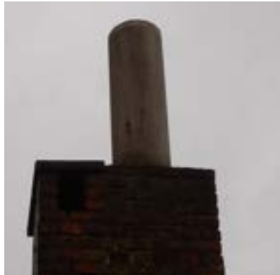
afb. 29: asbesthoudende schoorsteen
