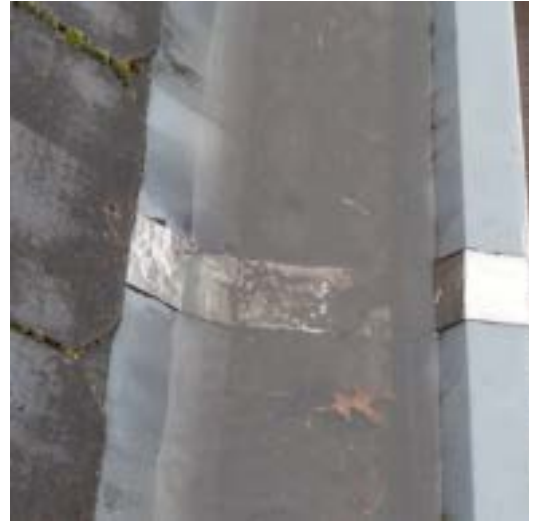
Dak [1]-noord: tijdelijke herstellingen.
