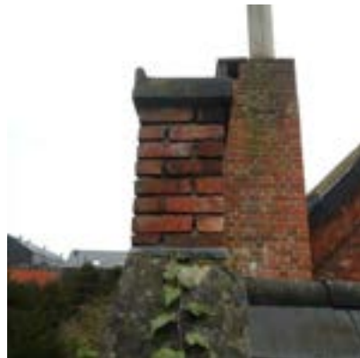
afb. 47: niet hervoeugd topstuk
