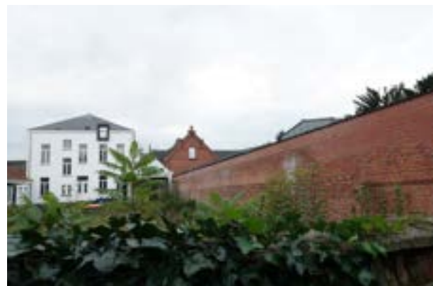
afb. 56: Blinde gevel vanuit naastgelegen herenhuis Van Schoubroeck
