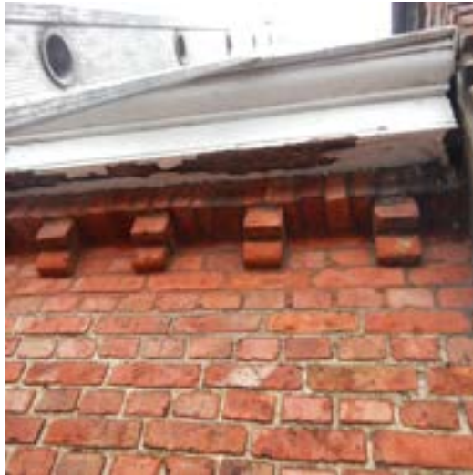
Vleugel [3]: afbladderende verf.
