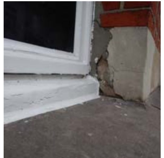
Beschadigd pleisterwerk.
