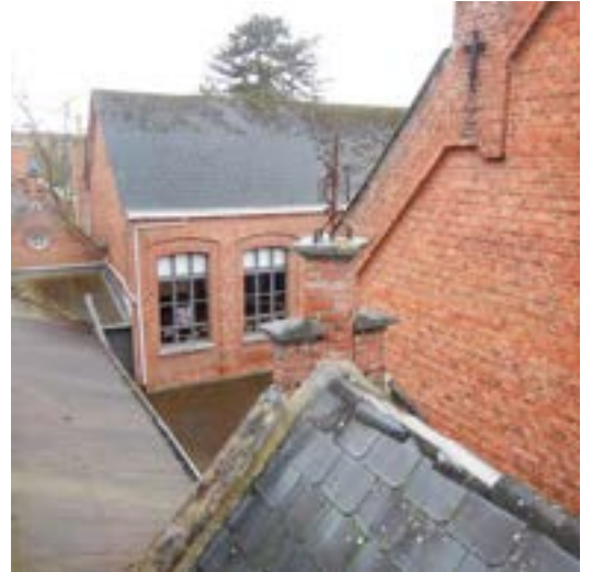
Dak [5]: ijzeren topstuk.
