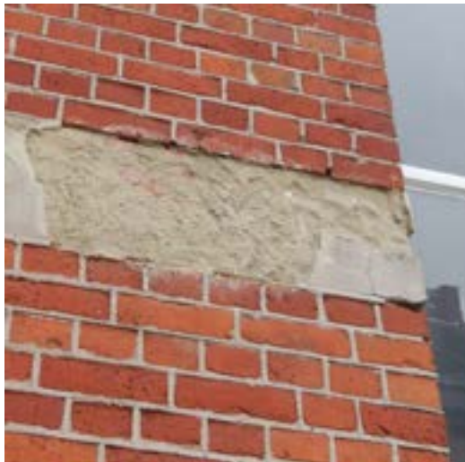
Beschadigd pleisterwerk.
