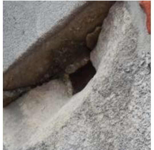
Vleugel [1]-oost: ingewerkte ijzeren dook in de natuursteen.
