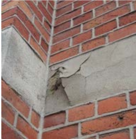
Beschadigd pleisterwerk.
