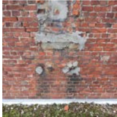
afb. 44: beschadigd metselwerk
