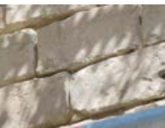
Verwijder verweerde voegen en losse mortelresten. haal de voegen voldoende diep uit, zonder de stenen te beschadigen
