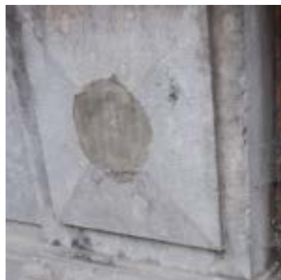
afb. 41: herstelling met cement
