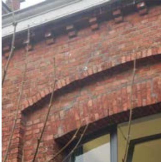
Vleugel [2]: scheurvorming.
