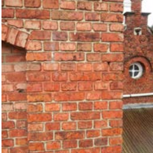
Voegwerk uitgevoerd in 2 kleuren.
