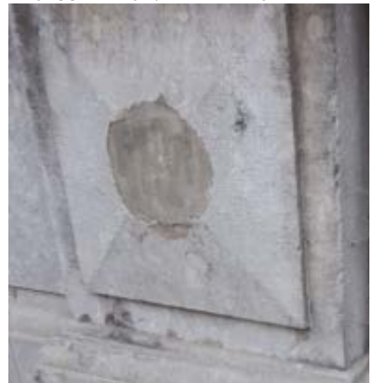
Vleugel [1]-zuid: herstelling met cement.
