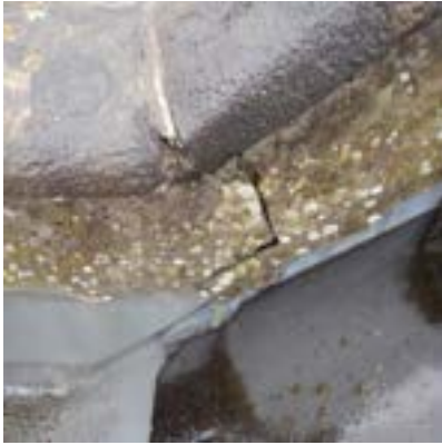
afb. 31: gebarsten cementering
