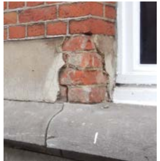
Beschadigd pleisterwerk.
