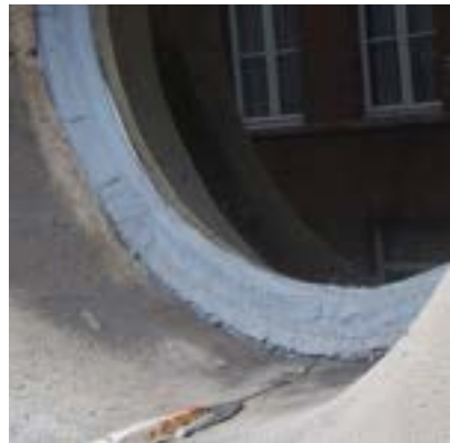
afb. 51: verweerd schrijnwerk
