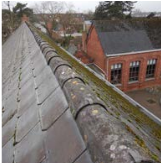
Dak [1]: verschil tussen een zuidelijk en een noordelijk dakvlak.
