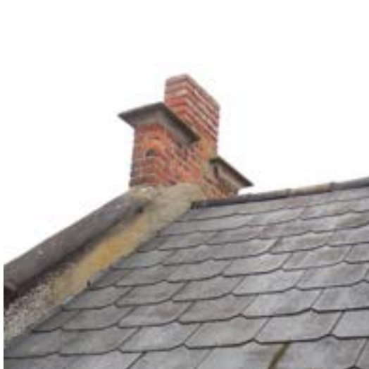
Vleugel [1]-west: ontbrekende deksteen.
