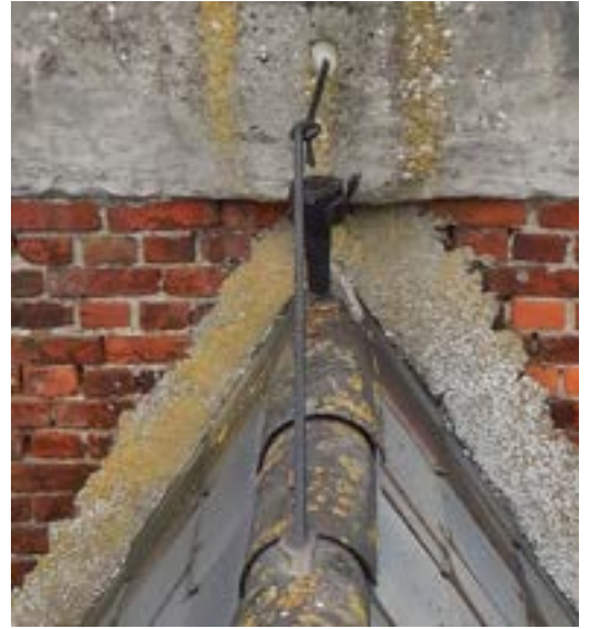
Vleugel [1a]: ijzeren anker.
