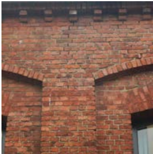
Vleugel [2]: scheurvorming.
