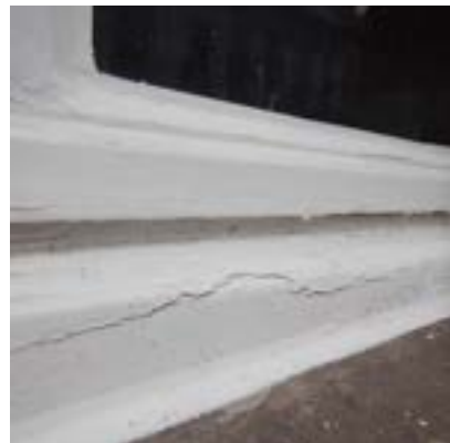
afb. 48: gebarsten verflaag
