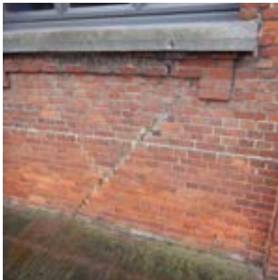
afb. 46: scheurvorming
