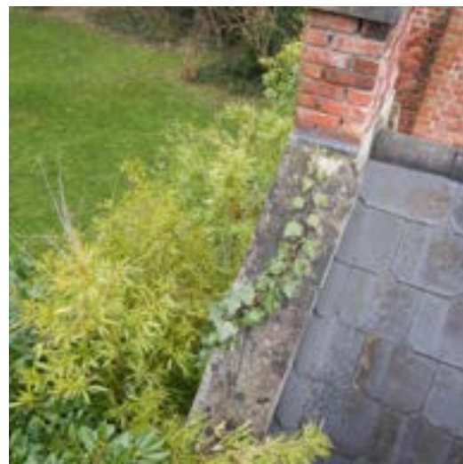
Vleugel [4]: klimop op de topgevel.
