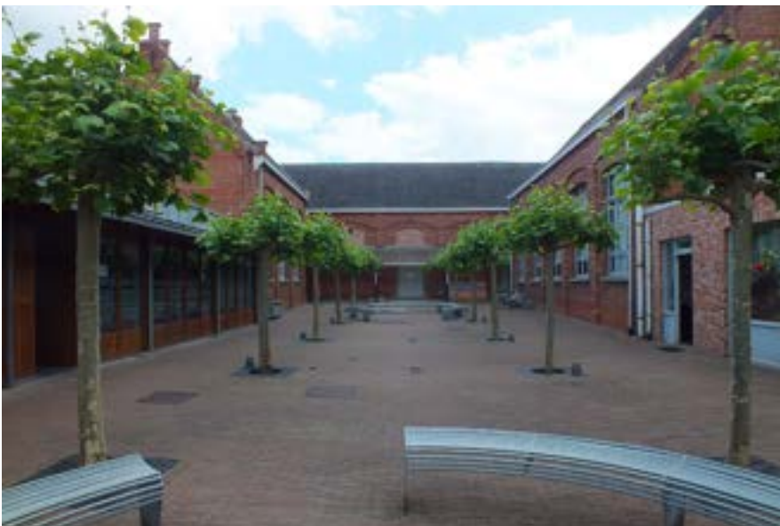
afb. 5: binnenkoer (zicht naar voorkant perceel)
