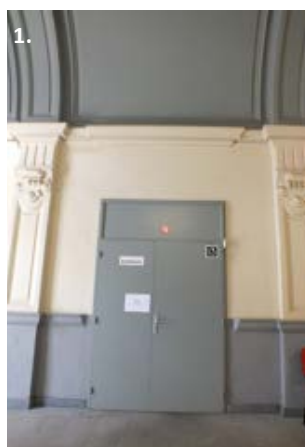
afb. 17: Detail pilasters inkomhal
