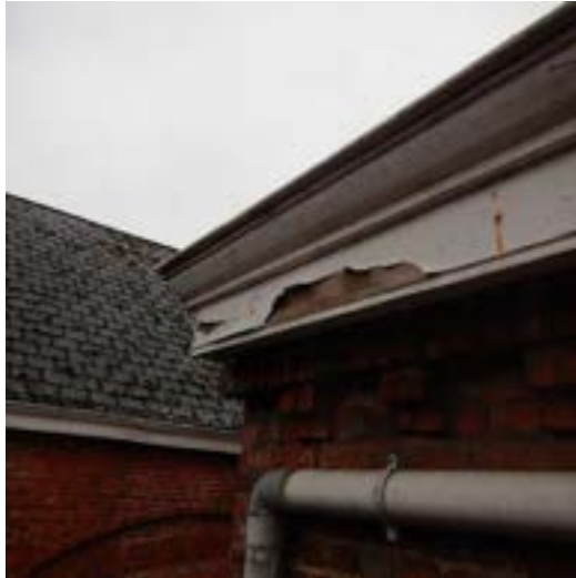
Vleugel [2]: afbladderende verf.
