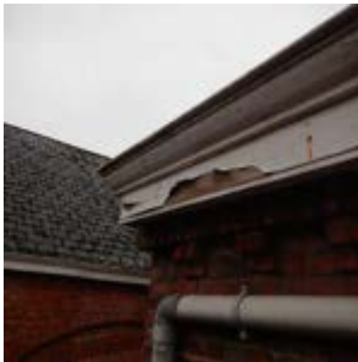
afb. 49: afbladderende verf
