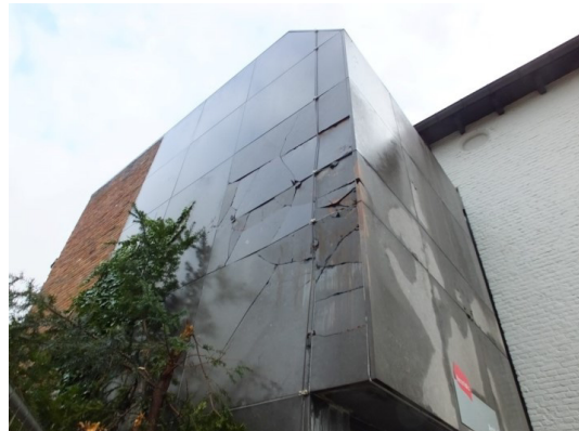
afb. 38: foto beschadigingen inkomportaal
