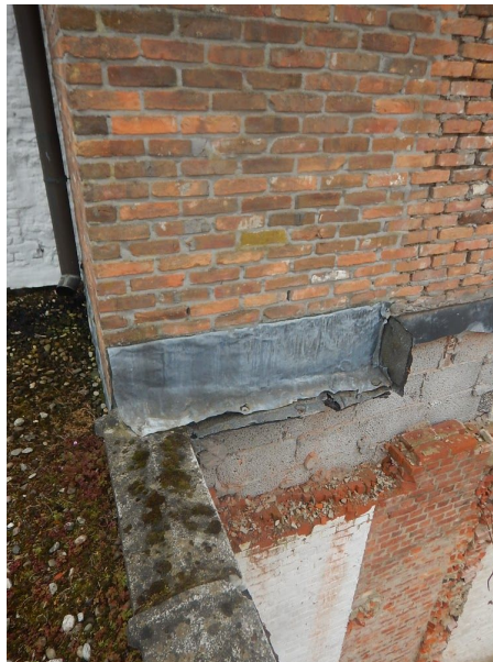
Binnenmuur waar de spouw open is.
