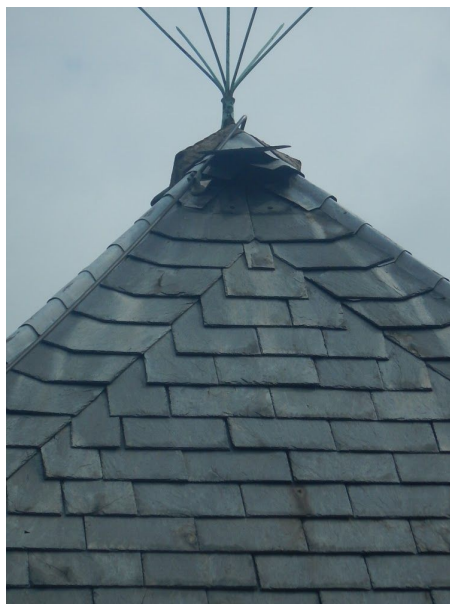
Dak [1]-west: aansluiting met de nok.
