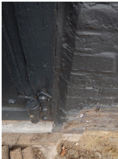
Inrottingen boven het scharnier.
