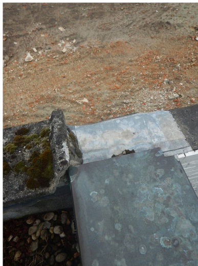
Dak [2]-slordige aansluiting met de tuinmuur.
