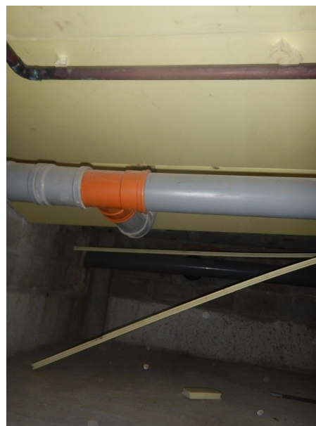
Weggefallen isolatieplaat.
