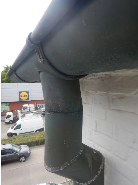
Uitgeschoven tapbuis en sporen van aantasting van rioolgas. Gescheurde naden van een tapbuis.
