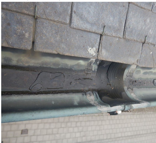
Ingescheurd uitzetstuk.
