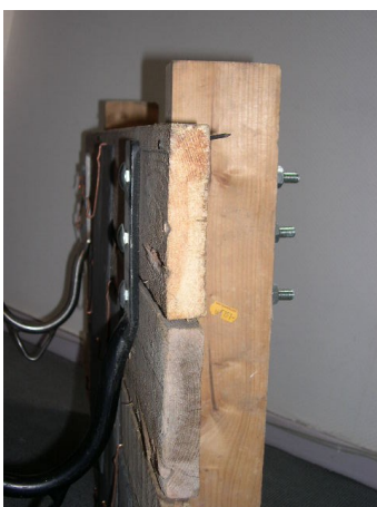
Bevestiging ladderhaken zijn bij voorkeur zichtbaar aan de binnenzijde.
