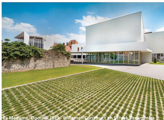
Ile Madame, Doornik (BE) - Willems Construct en Struik Verwo Infra
