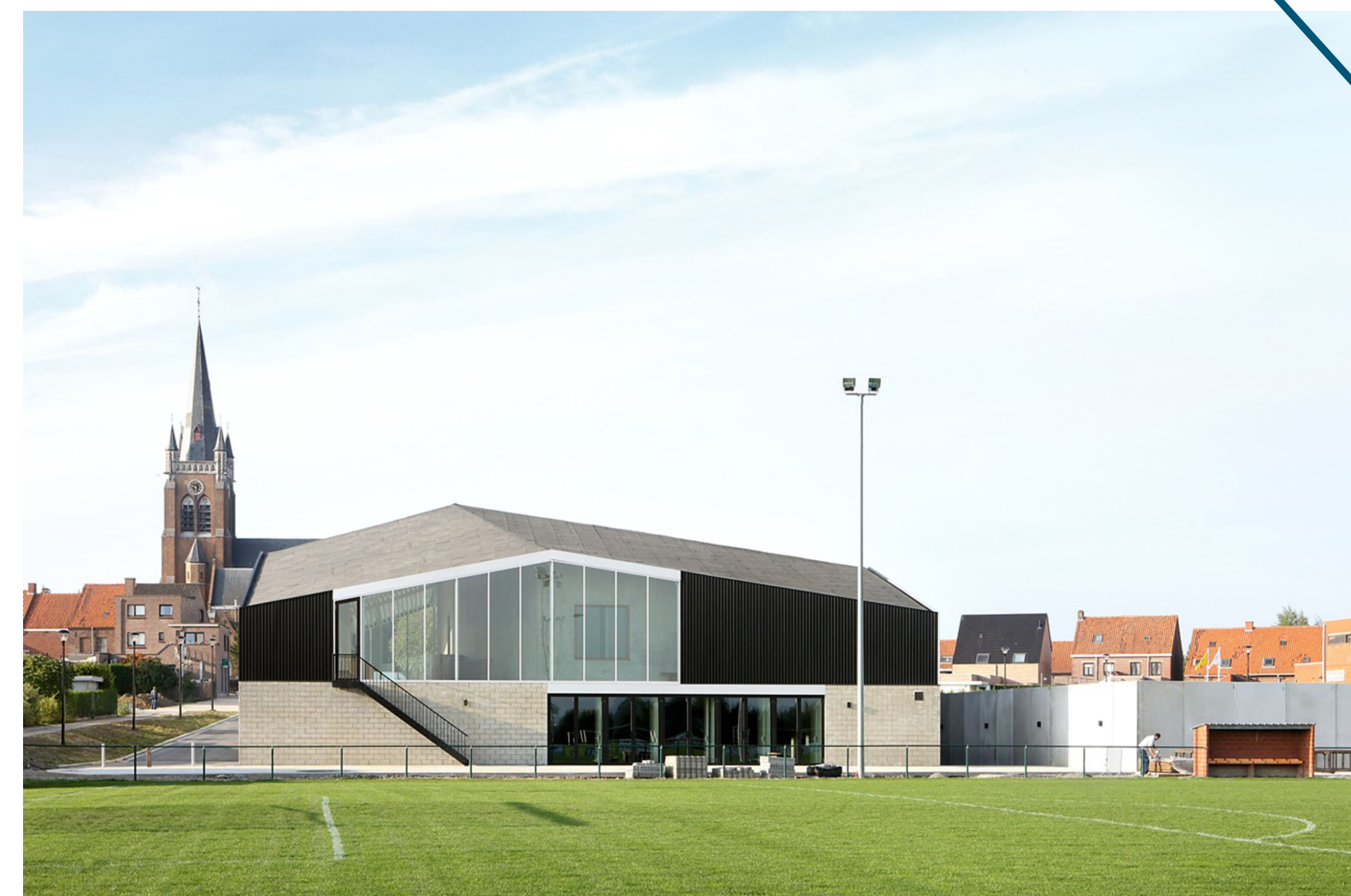
OC De Leege Platse Beselare - Dierendonckblanke architects
