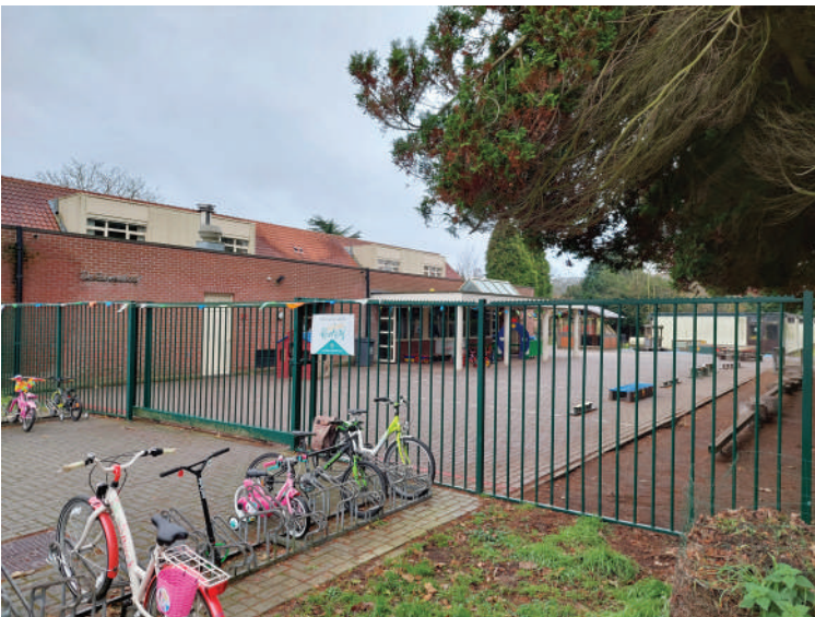
De Bijenkorf kent een autoluwe toegang via de Kleuterstraat
