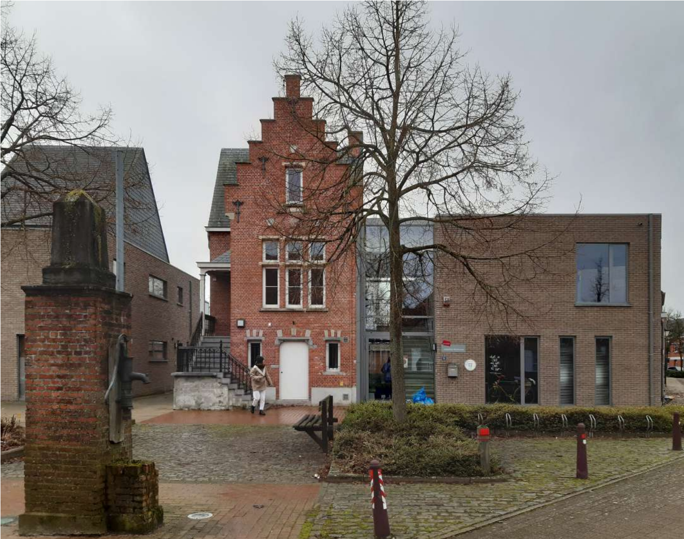
Historisch dorpshuis met recente aanbouw.
