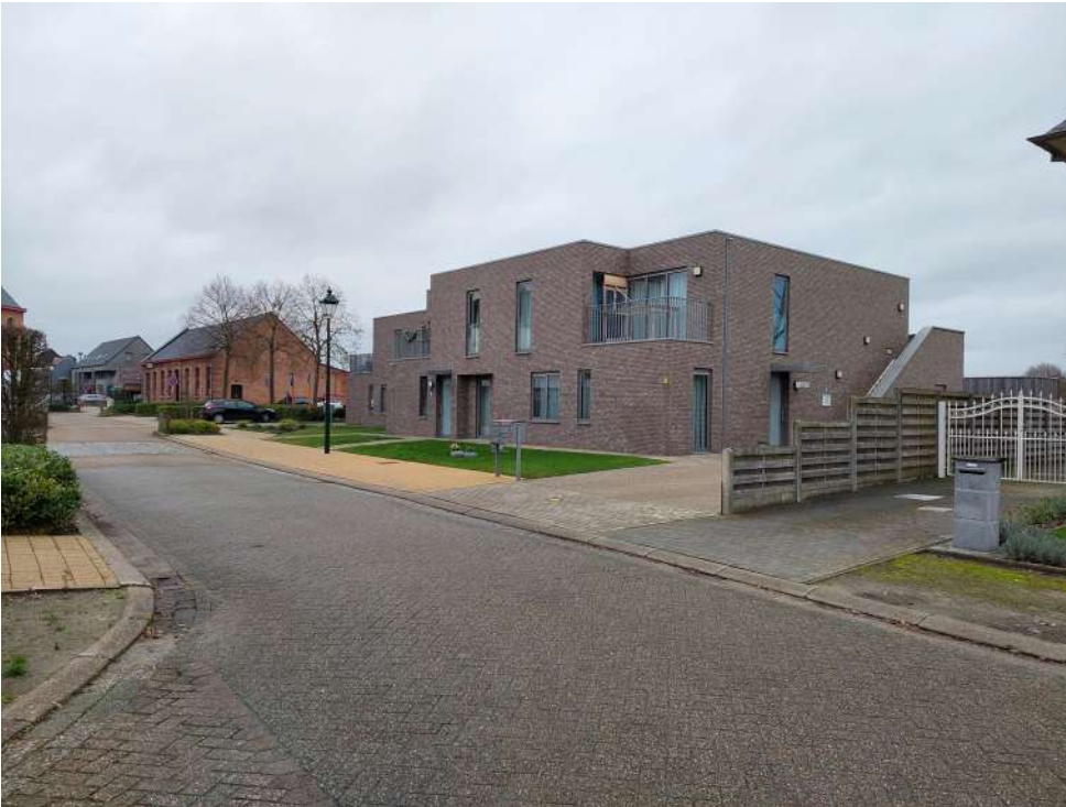
Recent nieuwbouwproject met 8 wooneenheden, Goorstraat
