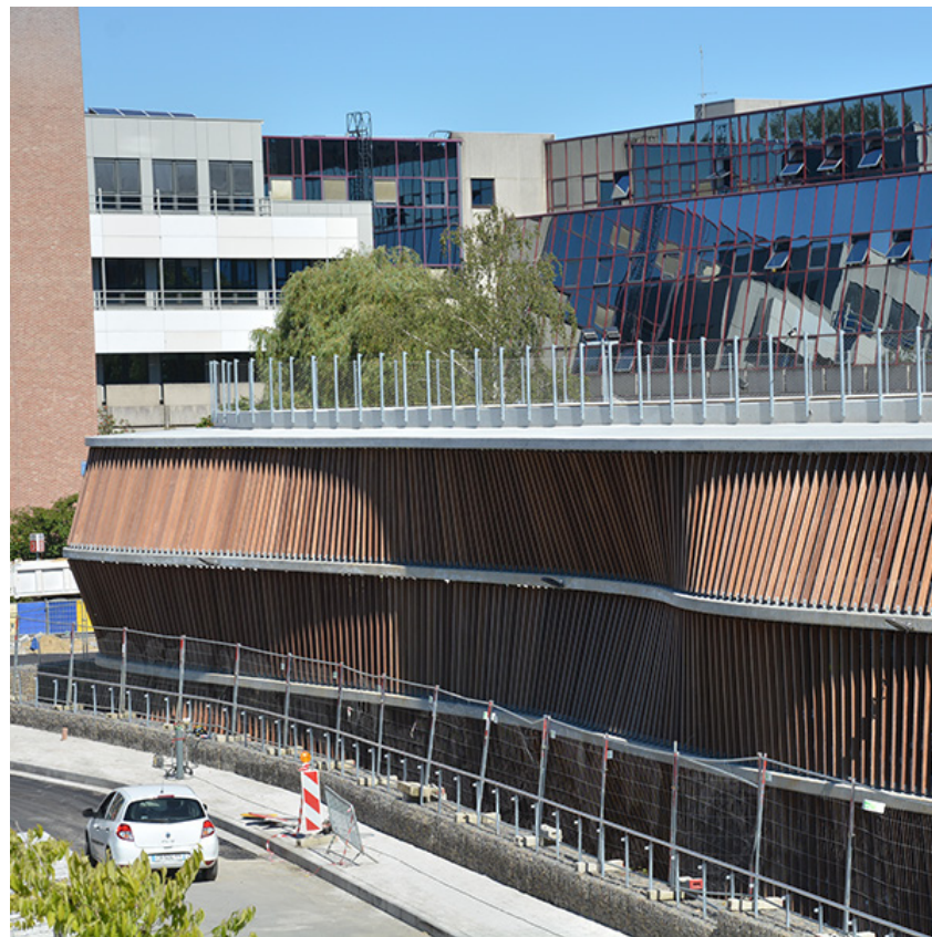
Parkeergebouw CU Saint-Luc, Namen, Modulo Architecten
