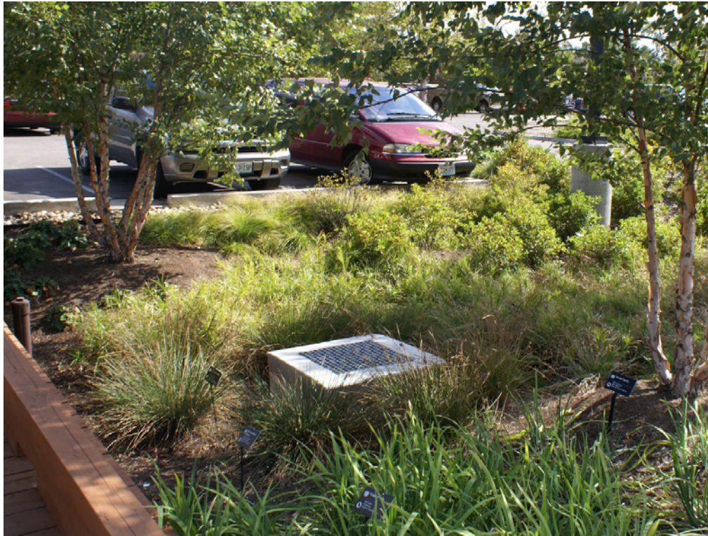
Verzonken waterinfrastructuur tussen de parkings Botanical Gardens Missouri, Pashtek + MTR
