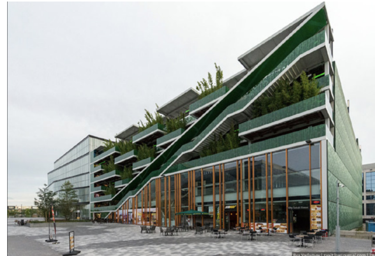
centrale parking Nieuwegein, Ilya Varlamov
