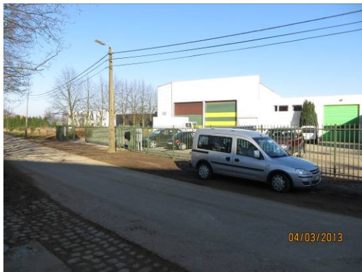
Het voorste gelegen gedeelte van het bedrijfsterein, aan Dompel
