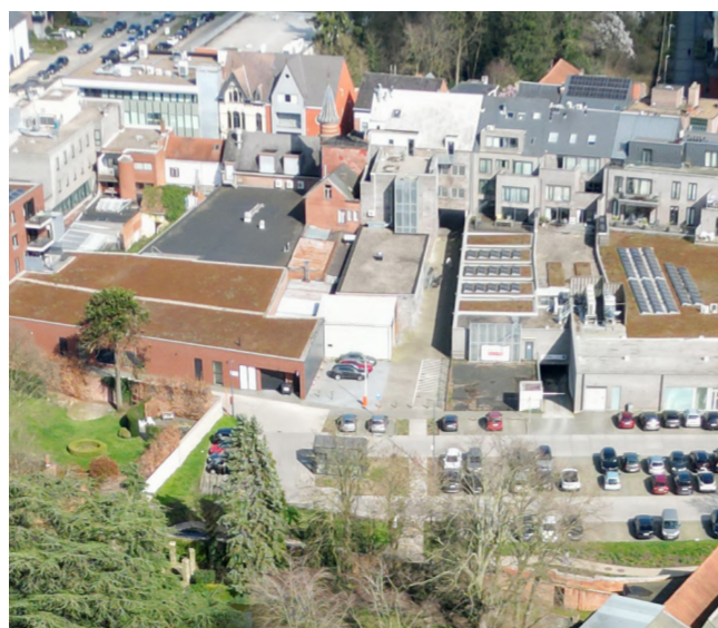
afb. 22: Oostelijke rand: achterzijde van winkelruimtes en inrit naar de bestaande ondergrondse parkeergarage
