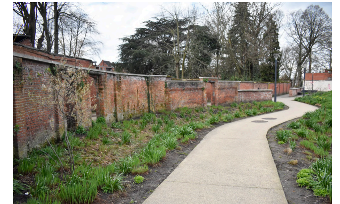
afb. 90: Trage verbinding 't Loopke
