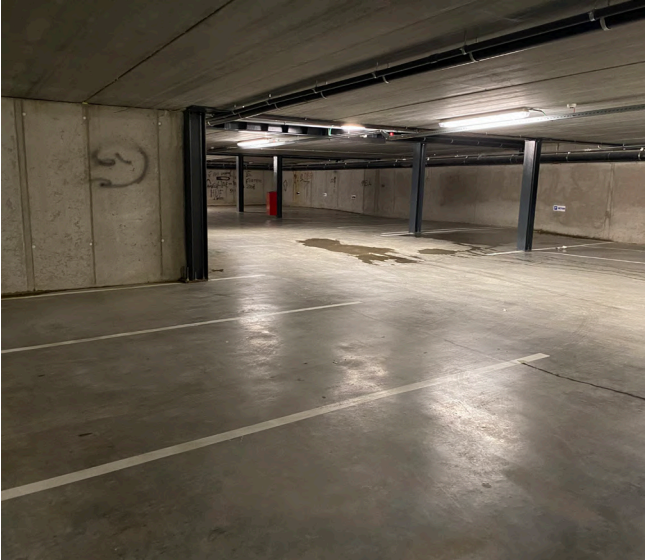
afb. 34: Bestaande ondergrondse parking
