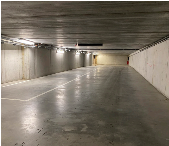
afb. 33: Bestaande ondergrondse parking
