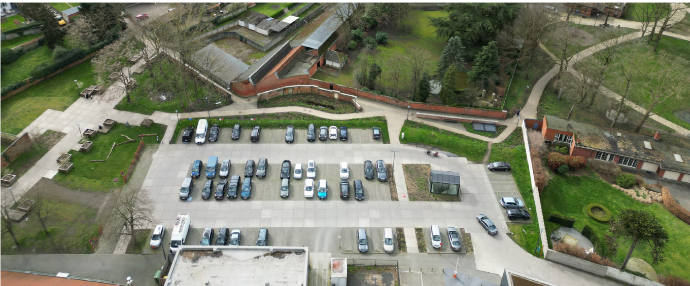
afb. 20: Tijdelijke parkeerzone in het binnengebied
