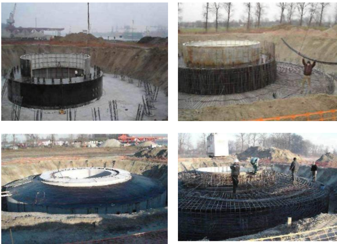
FIGUUR 6 FOTO'S VAN DE FUNDERING VAN EEN WINDTURBINE
