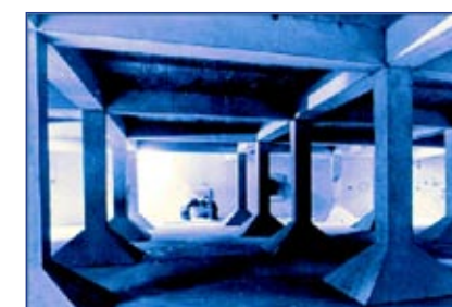
Reinwaterkelder - ondergronds gedeelte
