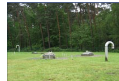
Reinwaterkelder - bovengronds gedeelte
