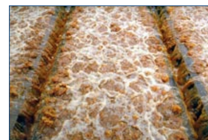
Spoelen van een zandfilter
