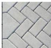
Betonklinkers als materiaal voor verhardingen berijdbare circulatieruimte
