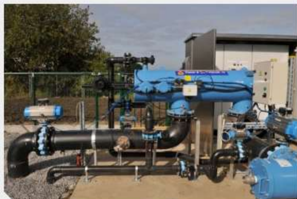
Filtratie-eenheid voor koelwater tbv Citrique in Tienen
