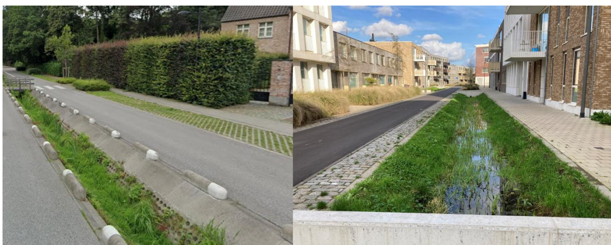
Figuur 19. Voorbeelden van hoe hemelwater kan worden geïntegreerd in het straatbeeld. Links) gracht tussen twee rijstroken in de Magdalena Vermeerschlaan (Hove); Rechts) infiltratieberm in Catharina Lundenhof (Hoboken).
