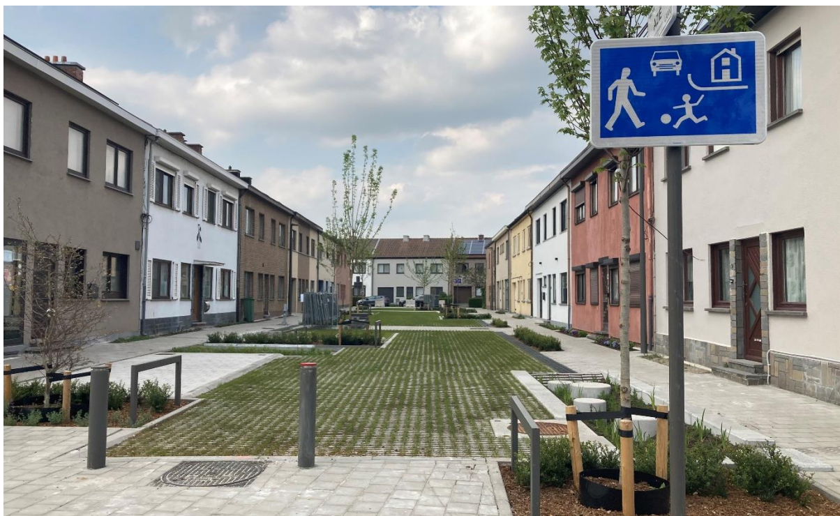
Figuur 46. Voorbeeld van een straat ingericht als een woonerf in de Aziëlaan (= Tuinstraat) in Wilrijk.
