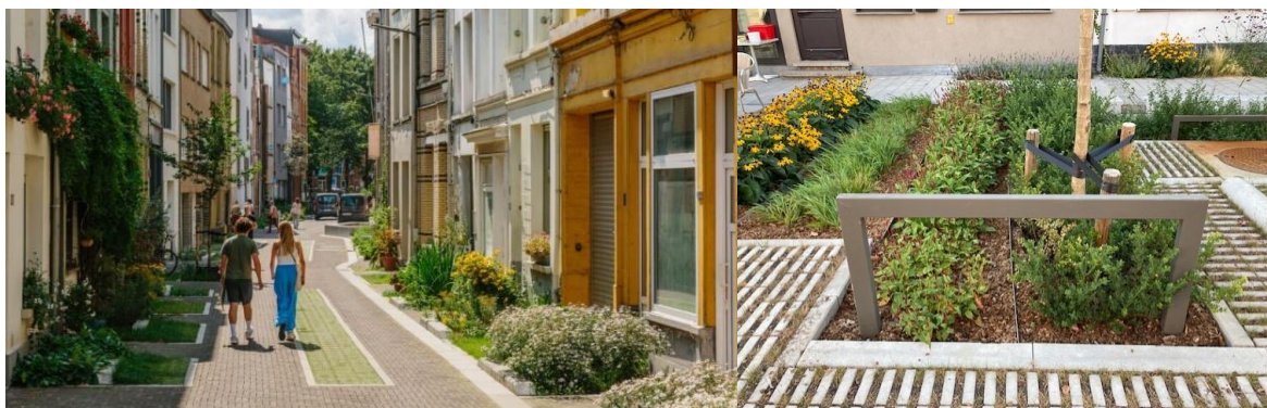
Figuur 12: Vlnr: (1) ontharding met boven- en ondergrondse infiltratie in centrum Antwerpen (© Aquafin); (2) Infiltrerende plantvakken in Aziëlaan (tuinstraat Wilrijk).
