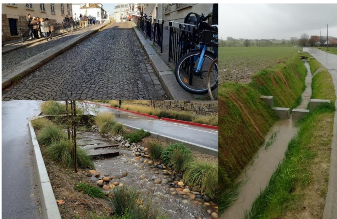
Figuur 16. Vlnr en vbno: (1) verhoogde borduren van voetpaden in Parijs (© Aquafin); (2) doorvoer waterloop in groenberm straat (© svrdesign.com) en (3) gracht met bufferschotten (© Kruisem).
