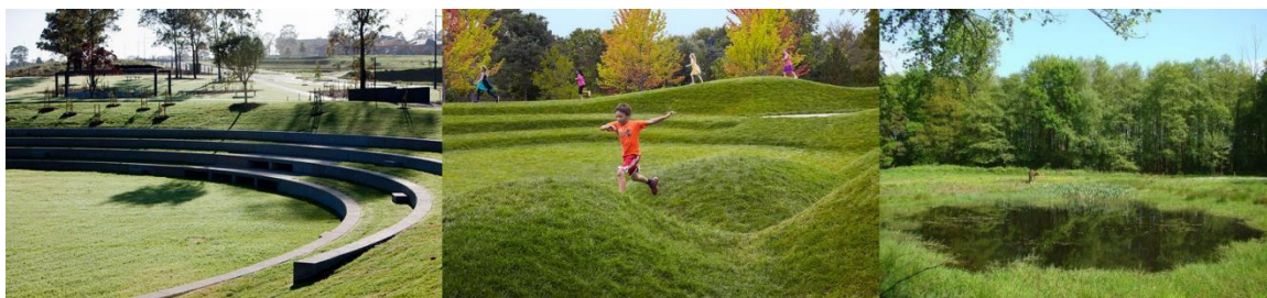
Figuur 49. Voorbeelden van bovenlokale buffers. Bovenlokale buffers kunnen meerdere functies combineren. Links en midden wordt de bufferfunctie gecombineerd met een recreatieve functie, waar de foto rechts infiltratie en buffering combineert in een wadi.
