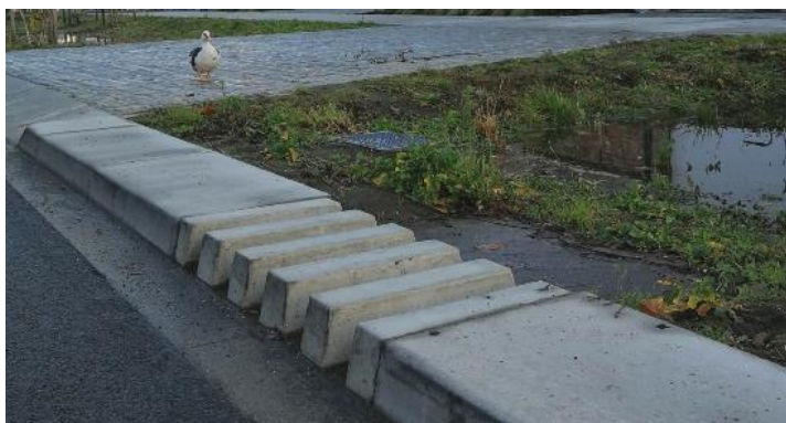
Figuur 47. Een voorbeeld van een boordsteen met spleten zoals toegepast in de Fortstraat in Mortsel (Bron: dbpubliekeruimte.info).
