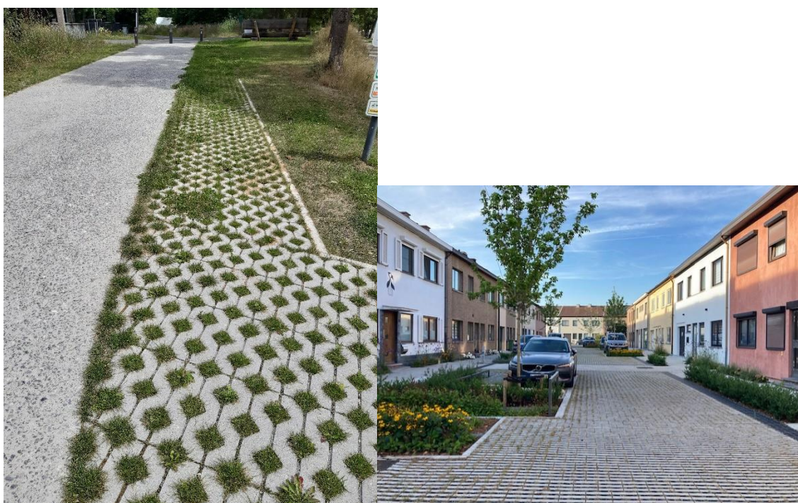
Figuur 10: Vlnr: (1) versmald voet-fietspad met uitwijkmogelijkheid over waterdoorlatende verharding (Overijse - © Aquafin); (2) tuinstraat met zowel rijweg als parkeervakken aangelegd in halfverharding (Aziëlaan, Wilrijk).
