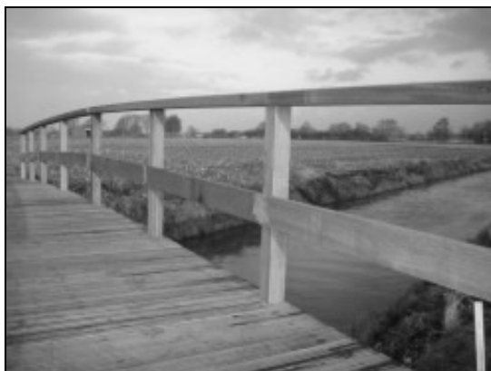
Fietsbrug over de Wimp
