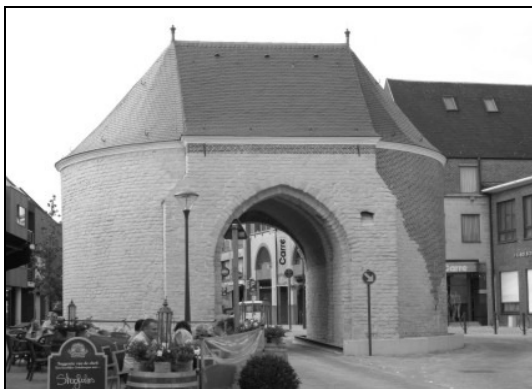
Zicht op gerestaureerde Bovenpoort vanuit Stadspoortstraat
