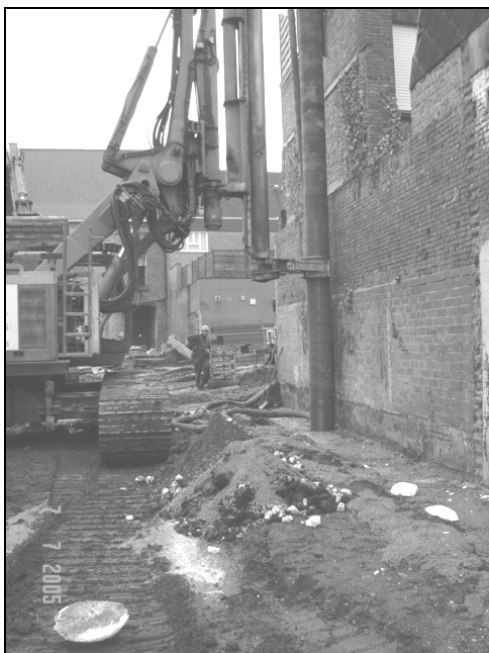
de bouwwerken zijn begonnen
