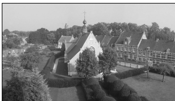
de gerestaureerde Begijnhofkerk
