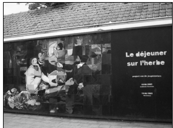
gevel in de Markgravenstraat
