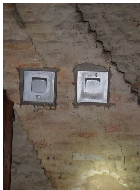
Lichte scheurvorming
