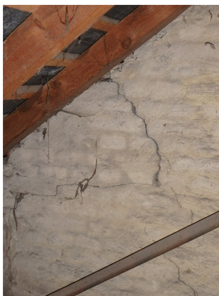
Lichte scheurvorming
