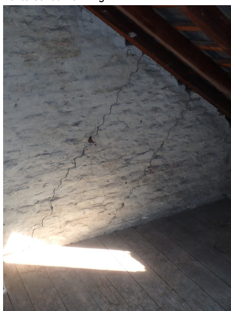
Structurele scheuren
