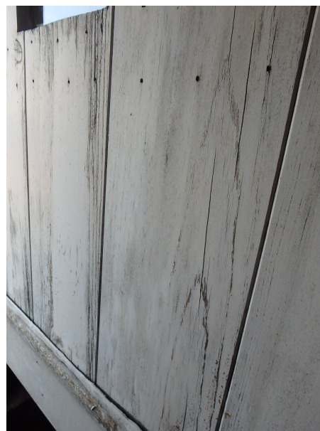
Het schilderwerk van de dakkapel is verschaald
