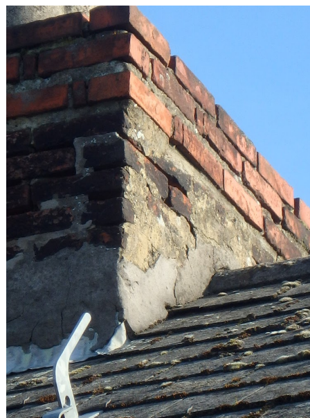
Uitgespoeld voegwerk en beschadige mortelaansluiting Uitgespoeld voegwerk en beschadige mortelaansluiting
