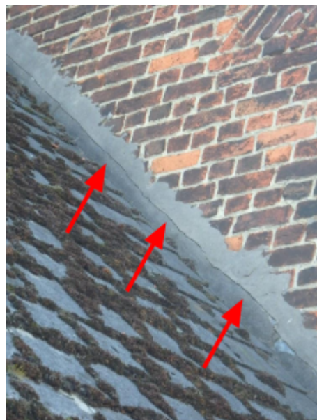
Mortelaansluitingen scheuren los
