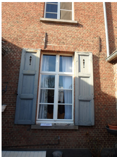
Het schilderwerk van de luiken is verschaald
