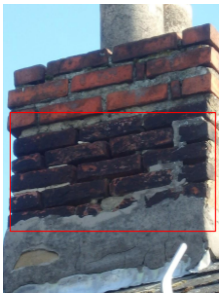
Uitgespoeld voegwerk en beschadige mortelaansluiting Uitgespoeld voegwerk en beschadige mortelaansluiting
