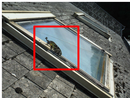
Kapotte scharnier van het dakraam.
