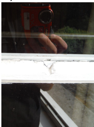
Dichtgemaakte condensgaatjes.
