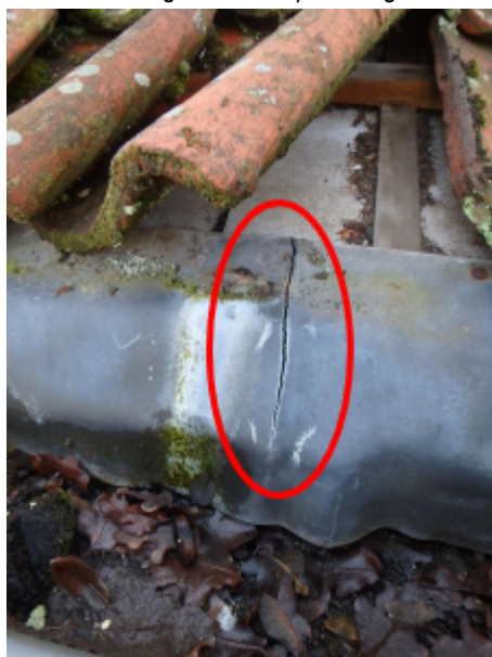
Voetlood is ingescheurd
