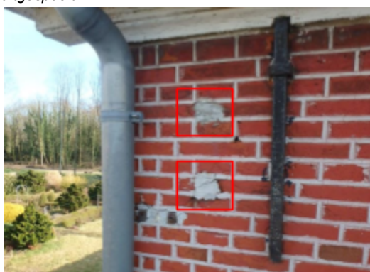
Vleugel [1]-west: restanten van een roestige bevestiging
