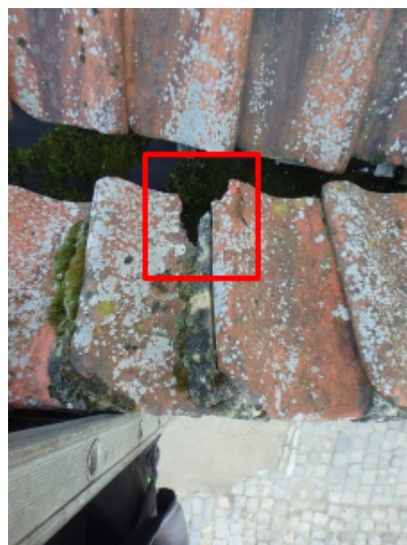
Een pan is gebroken
