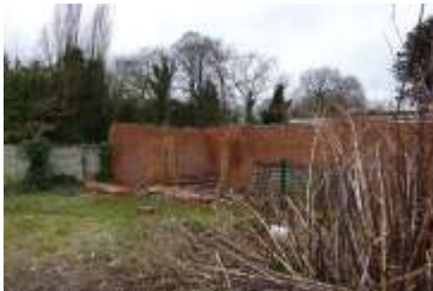
Braakliggende gronden met (vervallen) achterbouwen
