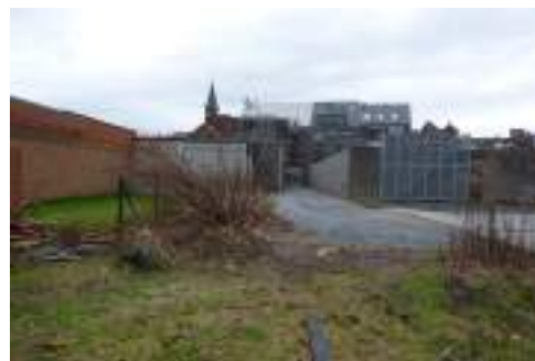
Doorsteek CAW, met links de achterbouw en grasvlakte van Moons en rechts een project van WL Immo
