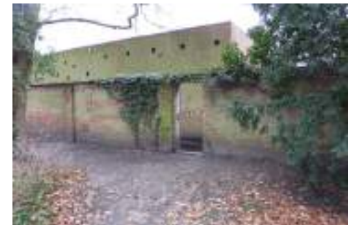
Bijgebouw bij de villa aan de Belgiëlaan
