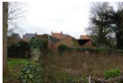
De achterbouw van het leegstaand pand loopt door tot aan 't Loopke
