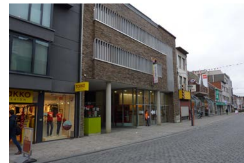
Gebouw CAW, met onderdoorgang naar het binnengebied, en links Hofkwartier 13-15-17
