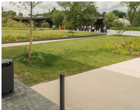
De paden krijgen een verharding in Grindpave. Dit is een natuurlijk ogend asfalt. Een materiaal dat een goed toegankelijk oppervlak vormt.
