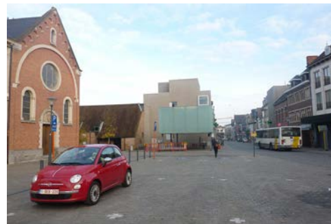
CM-gebouw, op de noordelijke kop van de Grote Markt
