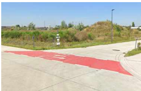
Figuur 18: Bedrijventerrein Wondelgemse Meersen (google, 2022) Een afgescheiden fietspad met groenbuffer loopt door op een kruising en wordt via een felrode wegmarkering zichtbaar gemaakt.
